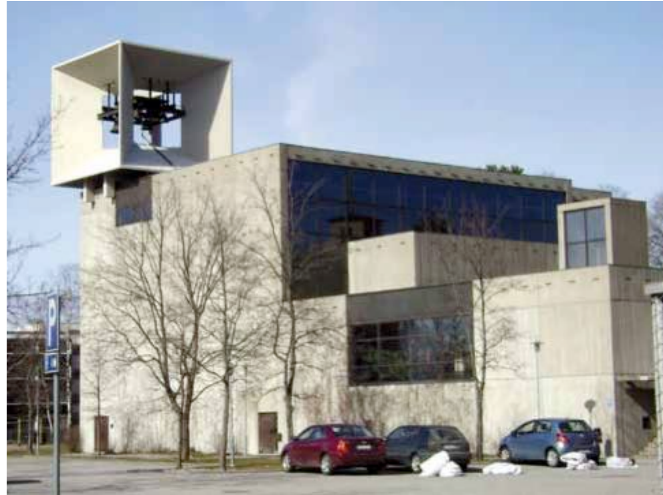
Ttt stilrent inhemskt exempel på betongbrutalism är Järvenpää kyrka, ritad av ERKKI ELOMAA .
