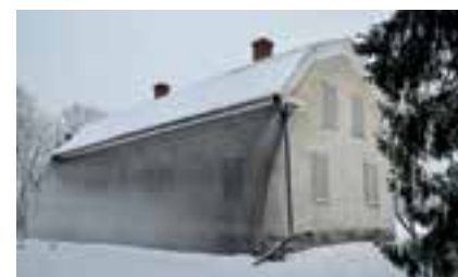
Skyddsnet skyddar rappningen under renoveringen.
